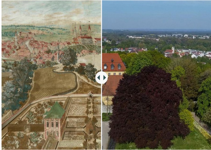
Valentin Gappnigg: Freising vom Niedergang (1700)
