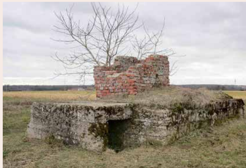
Ehemaliger Schutzbunker am Flugplatz Katterbach. Bild: R. Schmidt
